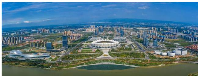
西安奥体中心为2021年第14届全国运动会主场馆，选址西安国际港务区，紧邻灞河。“一场两馆”总用地1089亩，总建筑面积52万 $m^2$ ，包含主体育场、体育馆等核心建筑。主体育场为甲级特大型体育建筑，总建筑面积15.2万 $m^2$ ，可容纳6万观众，立面主体由28组不同高度的V型柱支撑，形似“石榴花”，结构设计需兼顾造型美感与建造可行性。
