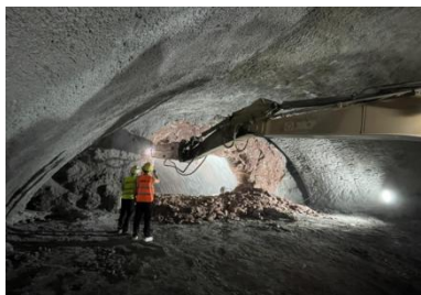
图1 隧道爆破作业面机械清渣与人员监控场景
