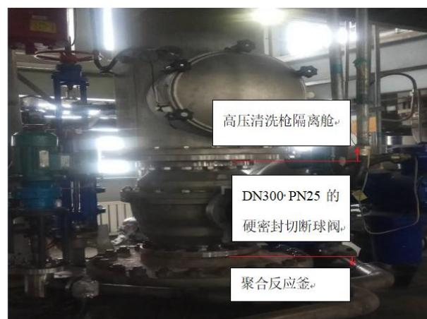
图1 聚合釜隔离阀安装位置
