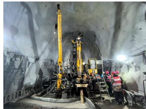
图1 定向钻机施工
