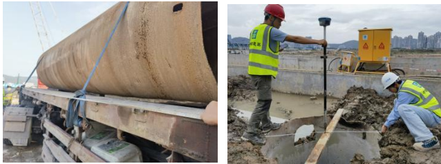
图 2 长护筒进场与埋设图
